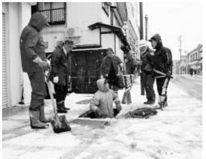
組合員が協力して流雪溝の点検作業を行う
