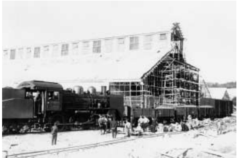
昭和32年日本電興専用線の新設作業 ※写真：東芝セラミックス(株)小国事業所提供
