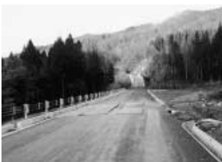
完成に向け工事が進む横川ダム湖岸線
