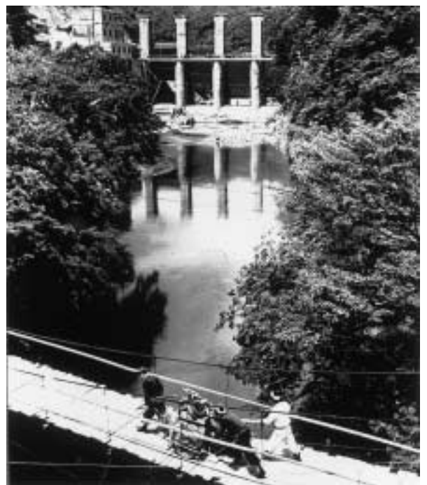
ゲートの取り付けを完了（手前は工事用の仮橋）
