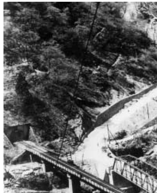
工事現場全景
