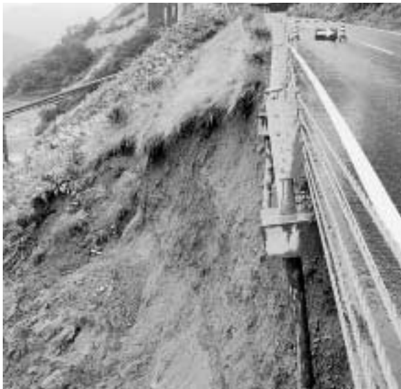
法面が崩落した町道横川ダム湖岸線（18日）
