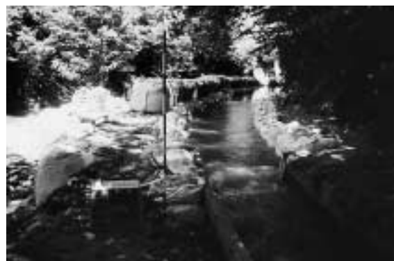
通水可能となった井の下幹線用水路
