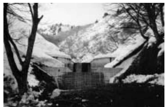
間伐材を利用した策淵治山ダム（手前）
