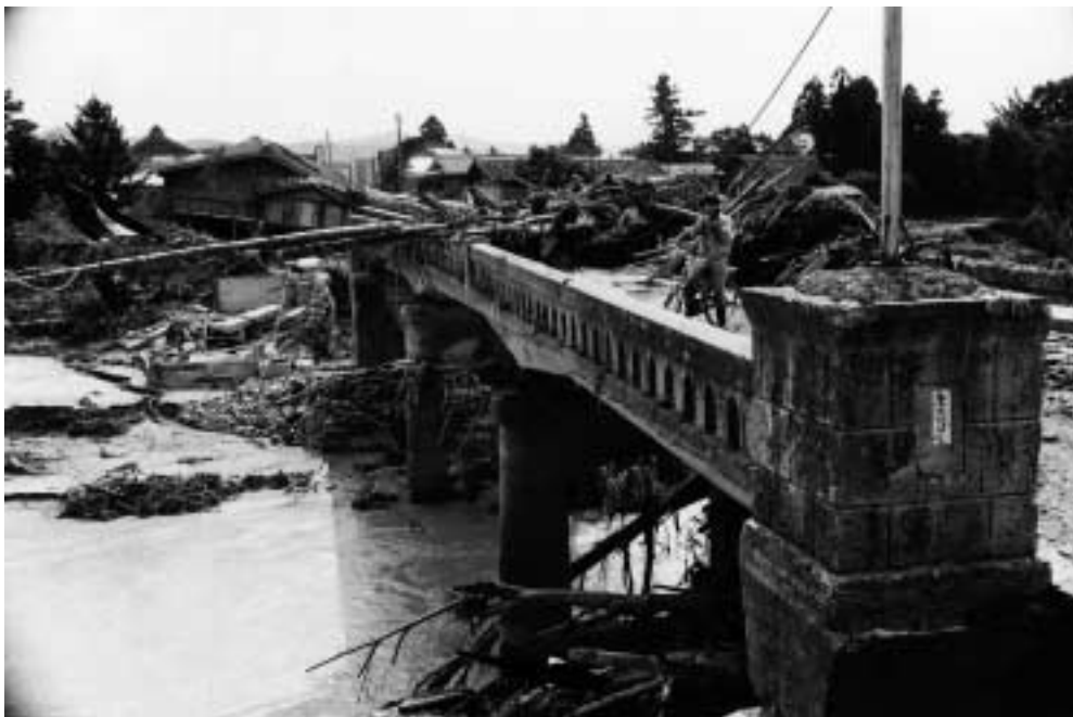
流木で山となった小国橋
