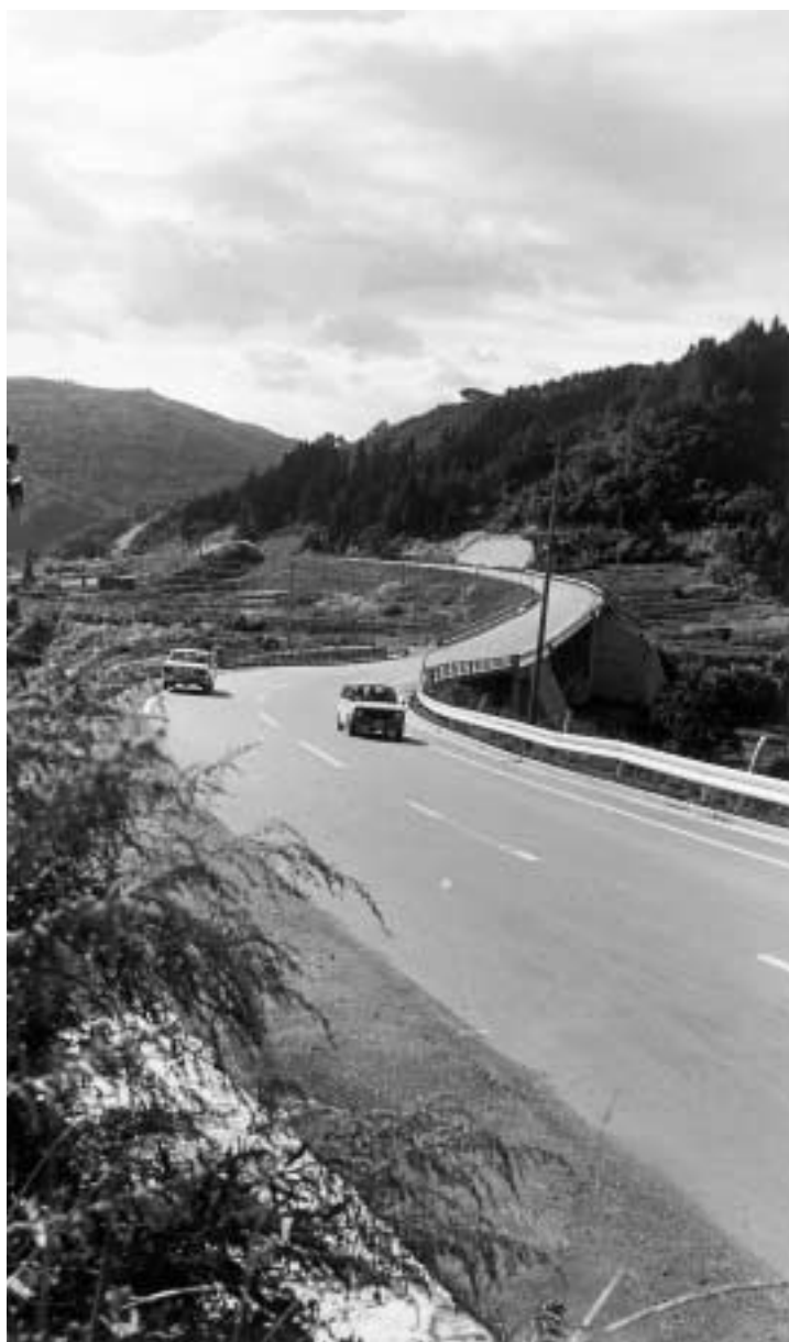
国道113号が全線開通した当時の間瀬付近の様子（昭和50年）
